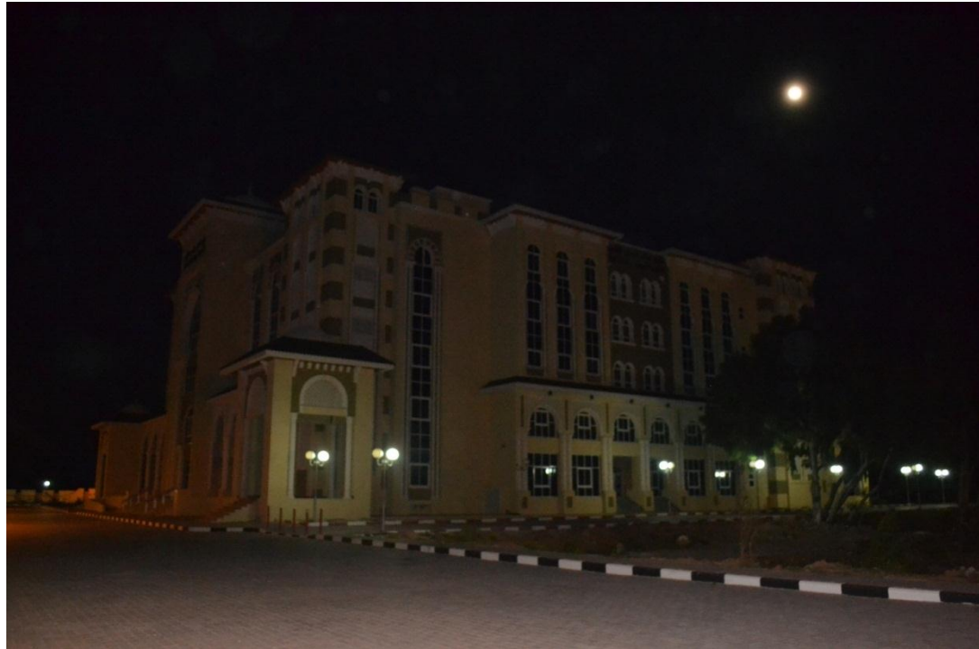
شكل (6-31) مقارنة بين شكل المبنى ليلاً والمقترح الضوئي.
